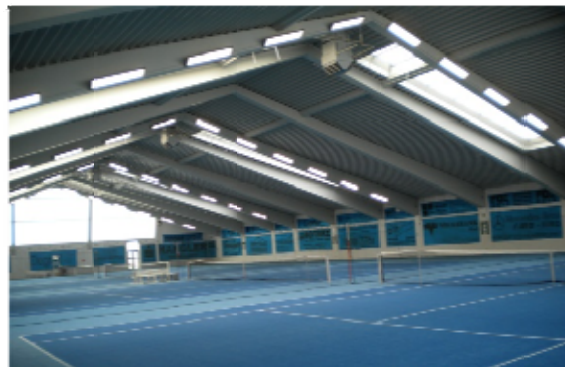
Después de la renovación
