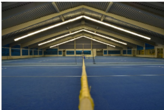
Antes de la renovación
