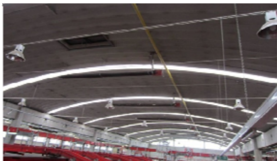
Antes de la renovación
