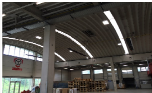
Después de la renovación
