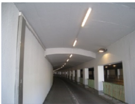
Después de la renovación
