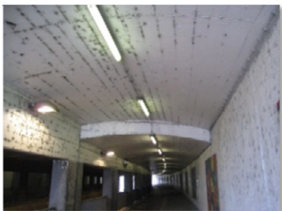
Antes de la renovación
